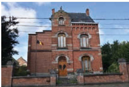
Maison de maître à Brugelette
