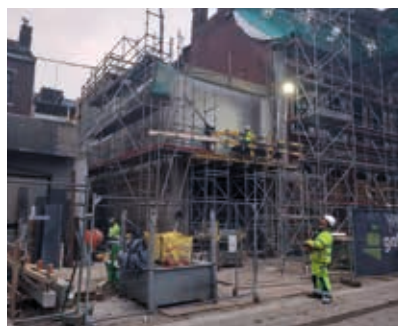
Travaux à l'Hôtel d'Ansembourg de Liège, 2024
