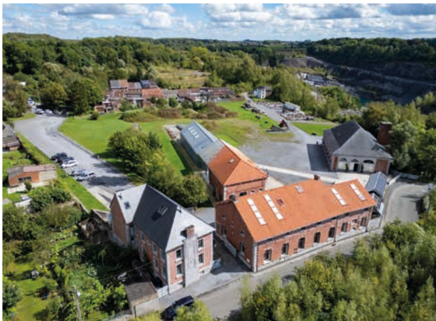
Site de Soignies, Pôle de la Pierre – Ancienne Grande Carrière Wincqz
