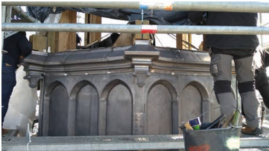
Église Saint-Martin d'Arlon. Restauration des ornements © bureau Arche Claire
