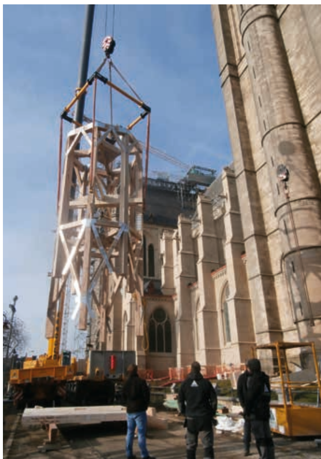
Église Saint-Martin d'Arlon. Placement de la nouvelle charpente
