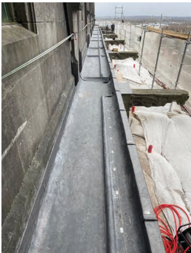
Chantier de restauration de la collégiale Sainte- Waudru de Mons
