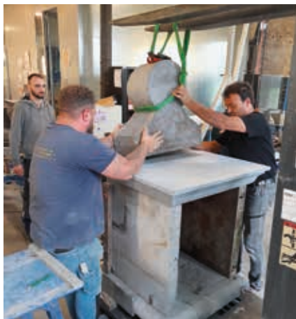
Formation en réparation de pierre – réparation de la potale du Bois du Grand Bon Dieu de Thuin, octobre 2024
