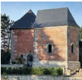
Pendant et après travaux © S. Lebrun
